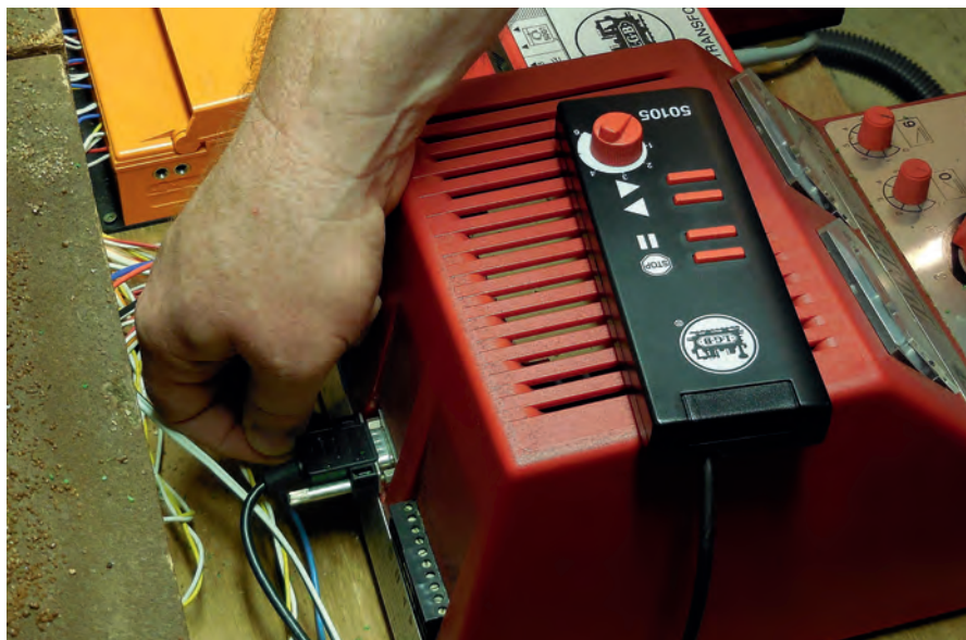
1 Der Jumbo-Fahrregler 50100 wird entfernt und durch das Gespann aus Schaltenteil und Central Station 2 ersetzt.
